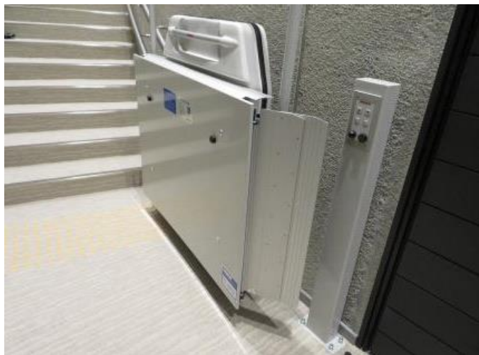
ホール舞台階までの斜行型の段差解消機
