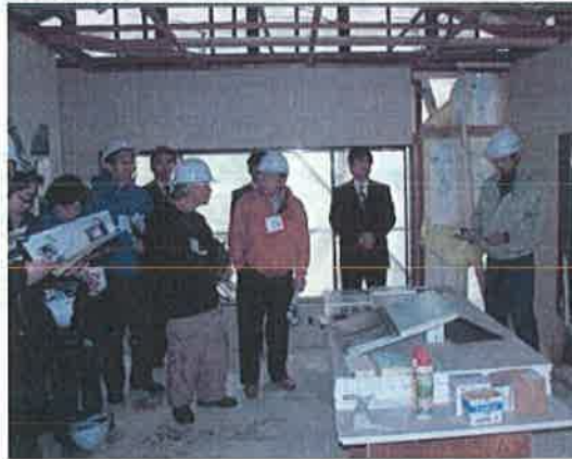
寄合い処の建築工事の解説
